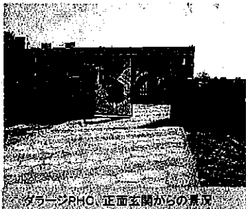
ダラーンPHC、正面玄関からの景況
